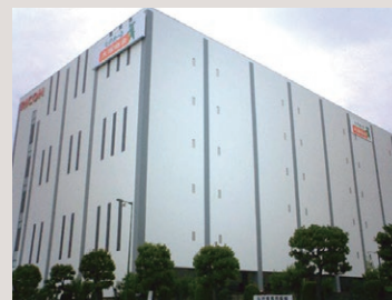
高島平物流センター（開設：2010年9月） 最新のピッキング機能を搭載。免震構造のほかいち早く全館LED照明を使用した
