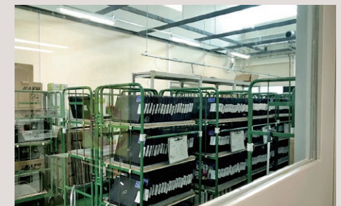
ODTセンター：国内最大級のPCデータ消去施設として、2006年に開設
