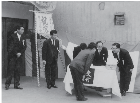
大森支店(自社ビル第1号)竣工式
