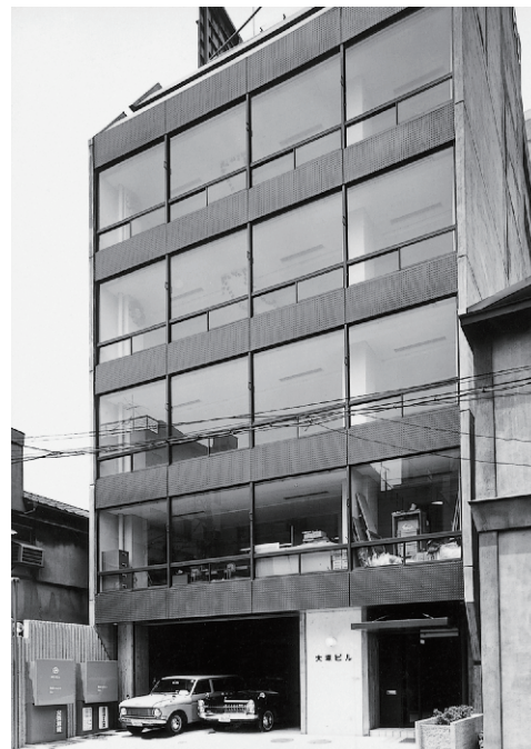
水道橋に竣工した本社ビル
