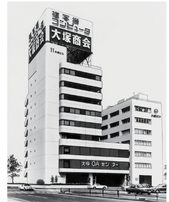
OAセンター&ショップ第1号店が入った横浜支店新館ビル
